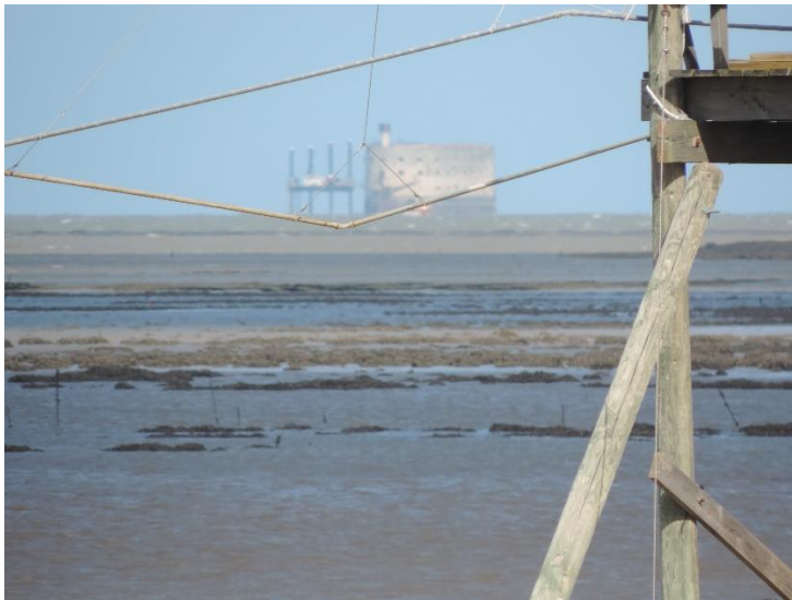
A l'Ouest de l'île Madame, dans le cadre de ce carrelet : Fort Boyard (cliché pris en 2015 après mise en place de la nouvelle plateforme d'accès). © A. Deshaies
